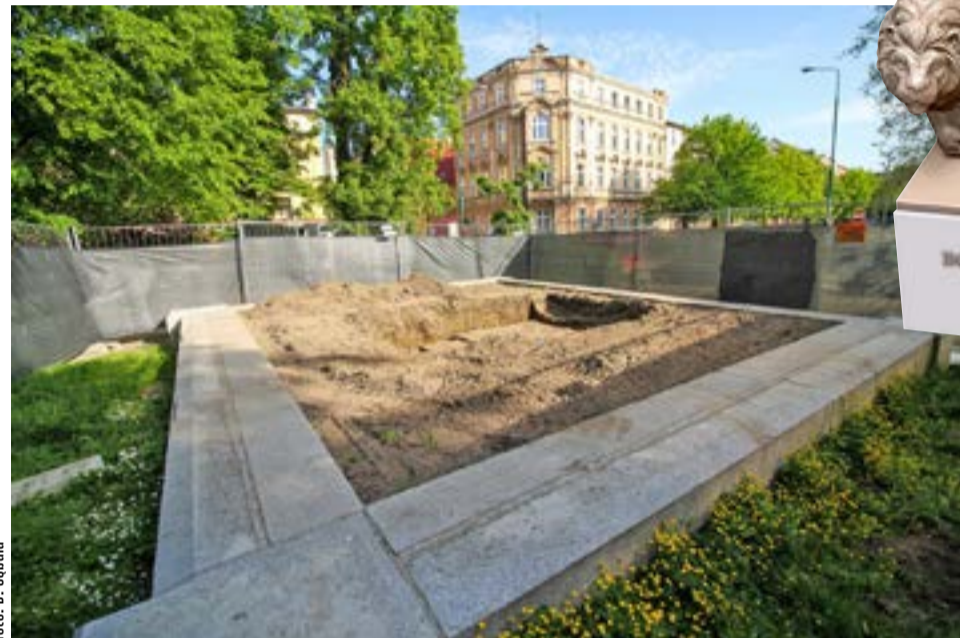
Pierwszy etap prac zostanie zakończony powstaniem cokołu.
